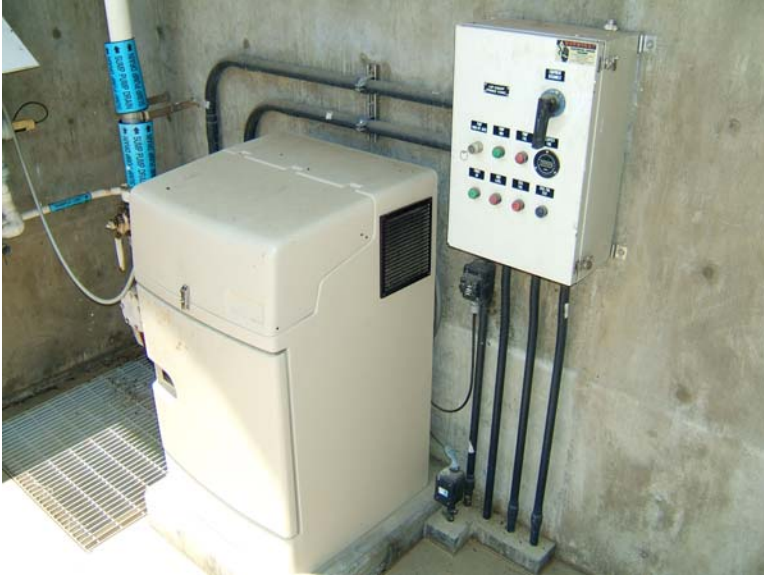
Effluent Sampler
