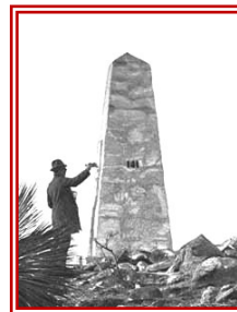
Mon. No. 141 (Masonry)
