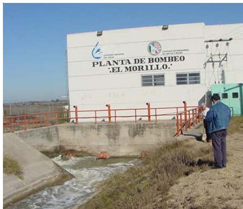
El Morillo Drain pumping plant.
